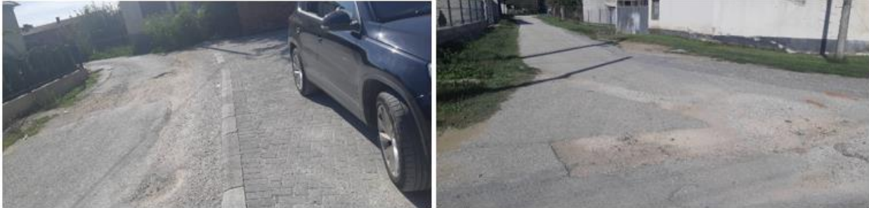
Видливи оштетувања на локалните улици „2“ и „3“ вклучени во реконструкцијата на втората фаза, општина Јегуновце
