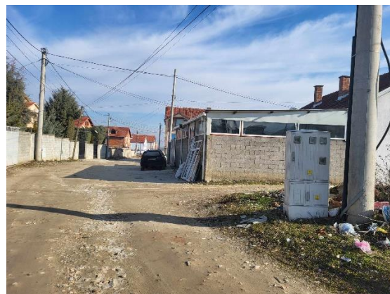
Слика 4. Работилница за производство на прозорци од алуминиум и пластика
